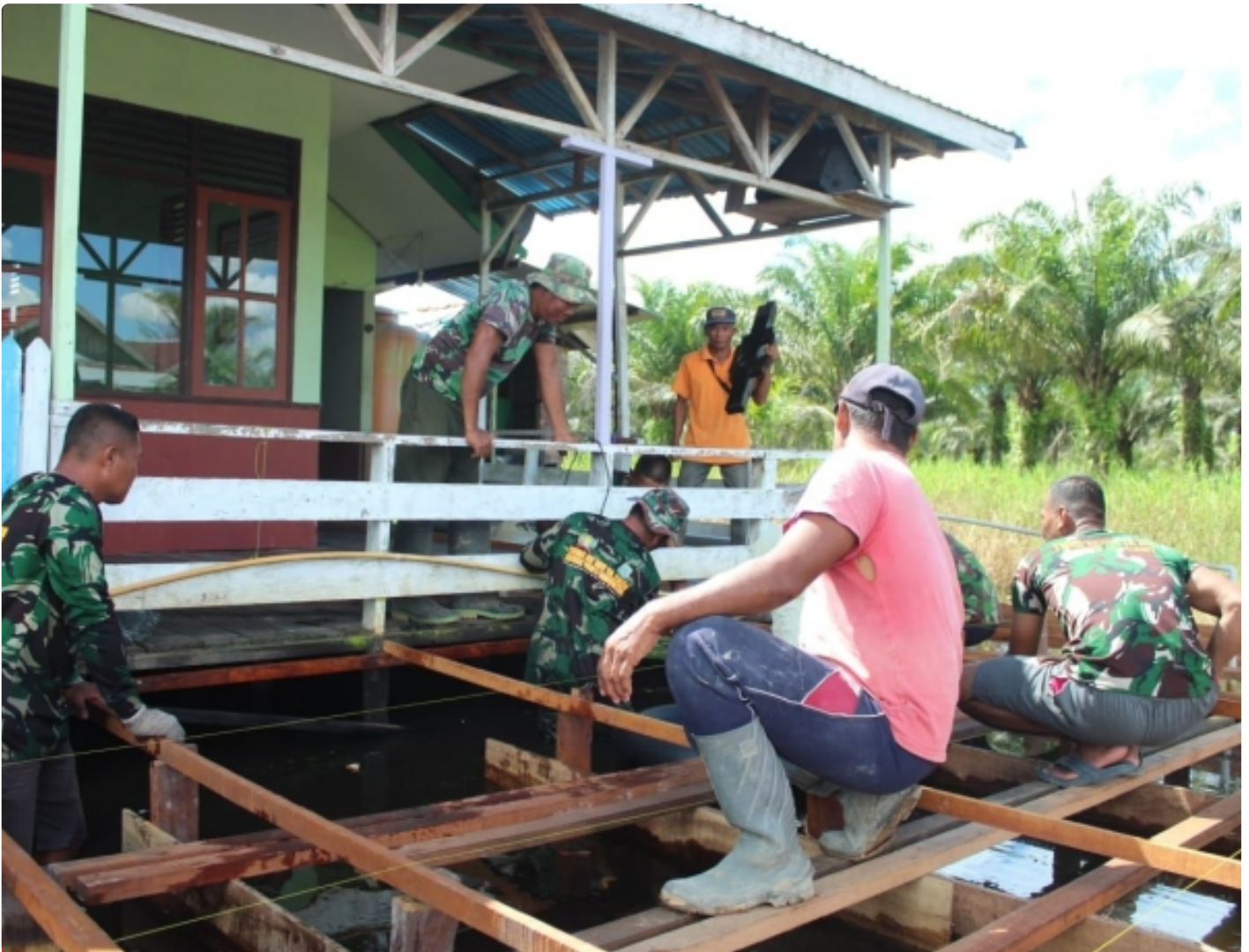
Warga Gotong Royong Bantu Satgas TMMMD 115 Rehab Masjid Jami' Al Hidayah
