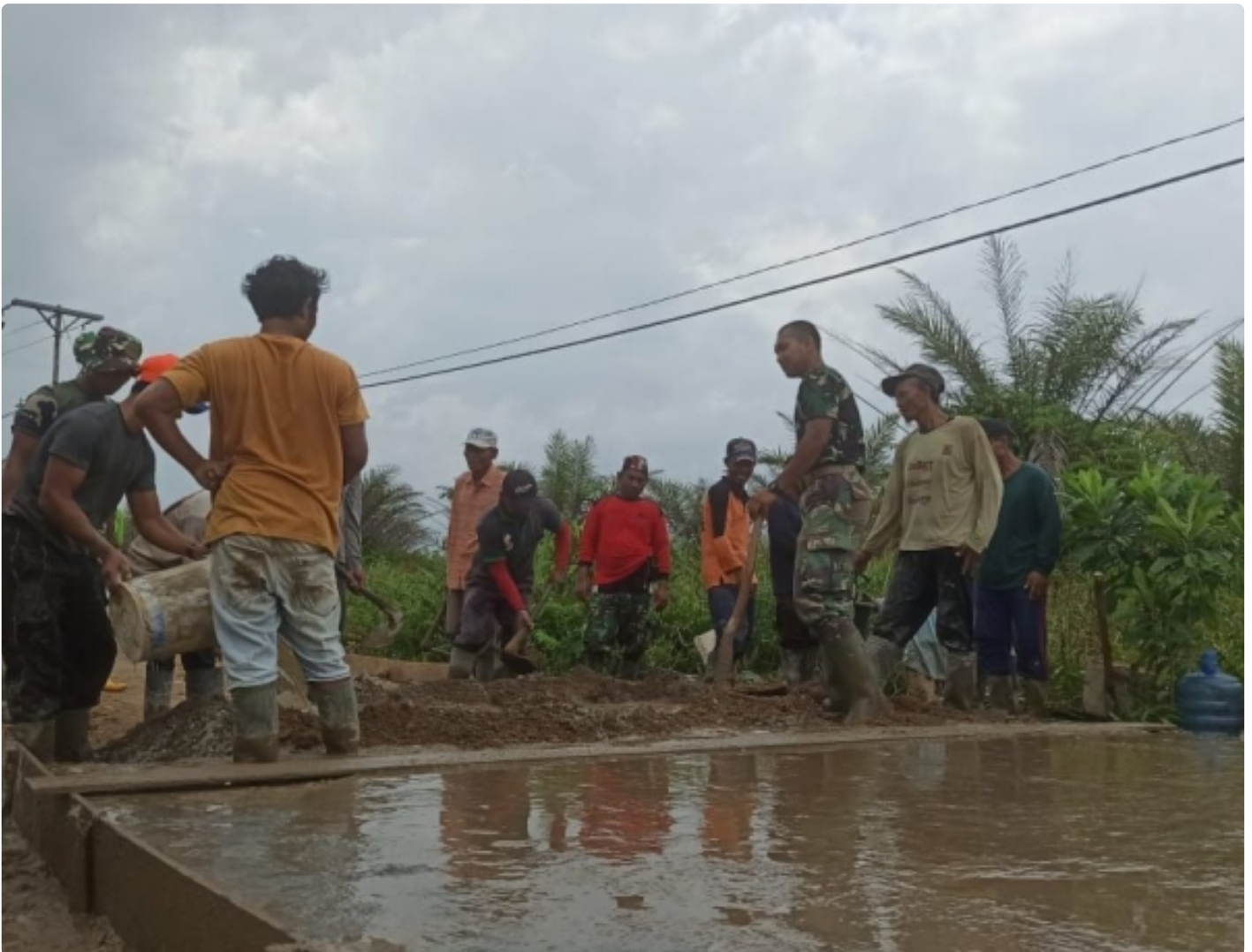
Semangat Warga Trans Lajar Papuyuan Rampungkan Jalan Desa
