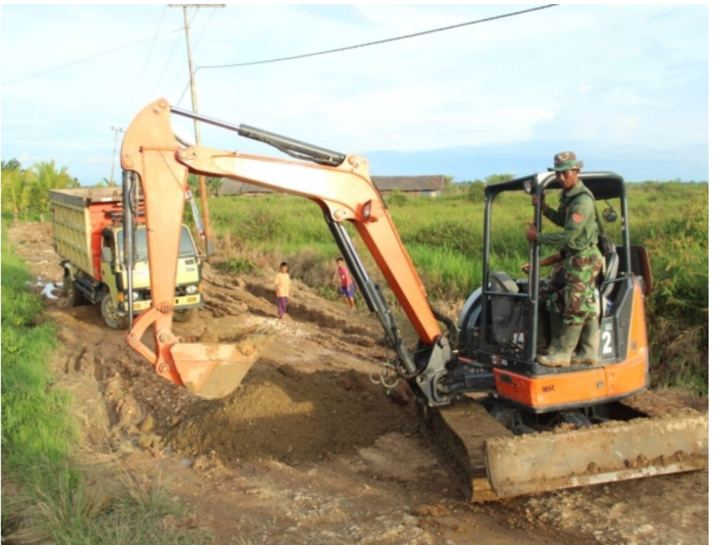
Satgas TMMD ke-115 Kodim 1001/Hsu-Blg Kerahkan Excavator
