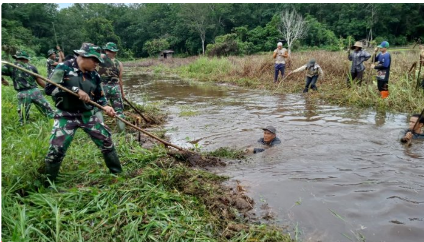
Cegah Batingsor Koramil 1001-05/Lampihong Bersihkan Saluran Air
